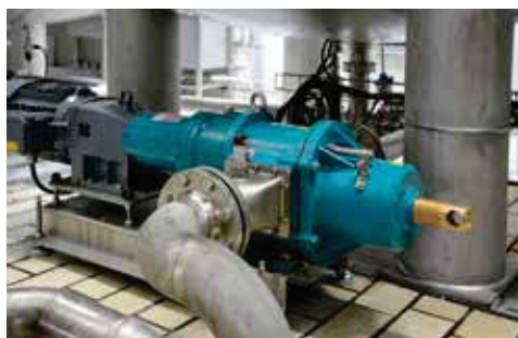
Pompe à lobes équipéE d'un variodeckel en montage ATEX
