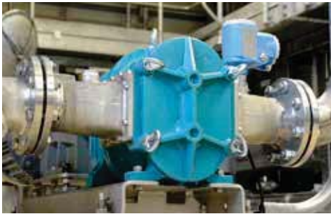
Pompe à lobes BLUELine destinée au pompage des solvants
