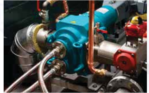
Pompe à lobe BLUEline avec double enveloppe de réchauffage
